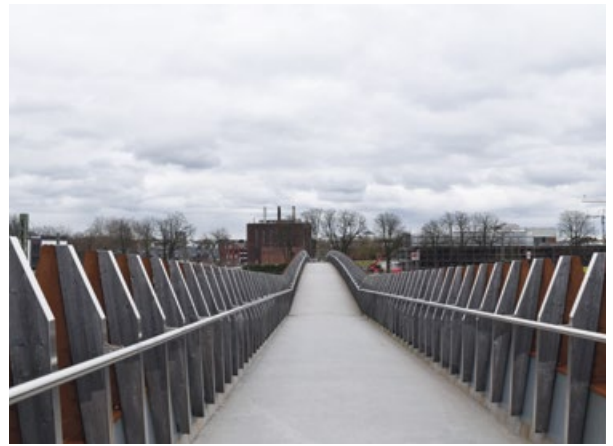
Die Campus-Brücke verbindet Opladen mit dem Ostteil der Bahnstadt. Quelle: Bundestransferstelle
