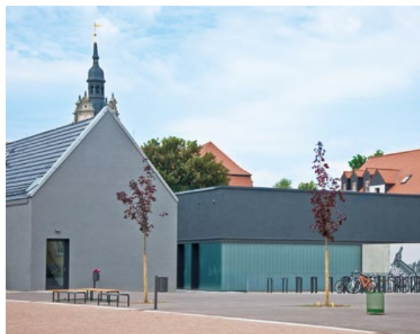
Nebengebäude und Sporthalle des Campus Technicus Quelle: Thomas Weiß, Erfurt
