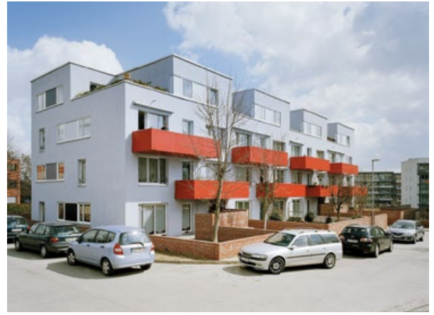
Wohngebäude nach dem aufwendigen Umbau. Quelle: Jean-Luc Valentin, Forster Architekten
