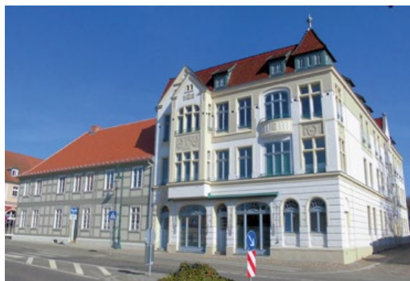
Direkt am westlichen Stadteingang haben die kommunale Wohnungsgesellschaft (rechtes Gebäude) und die Wohnungsbaugenossenschaft (linkes Gebäude) ein gemeinsames Sanierungsvorhaben durchgeführt. Quelle: Bundestransferstelle
