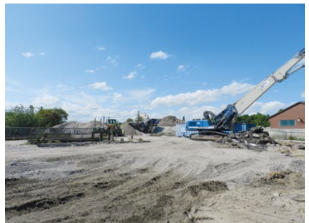
Rückbauarbeiten auf dem Gelände der geplanten Wasserverbindung Quelle: BIG Städtebau
