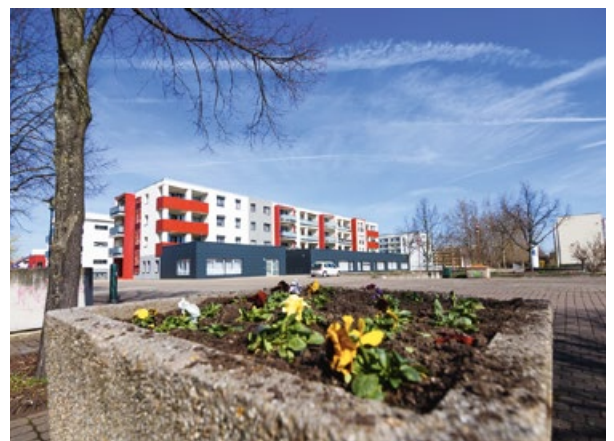
Langfristig zu erhaltende Wohnquartiere wurden baulich aufgewertet. Quelle: Julia Thieme
