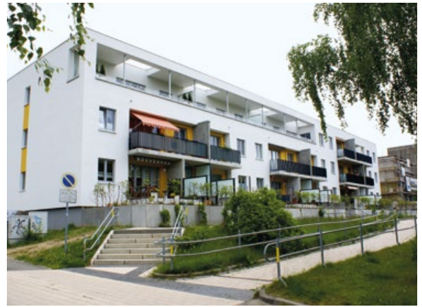
Wohngebäude Wuppertaler Straße 22 – 24 nach der Sanierung. Quelle: Schweriner Wohnungsbaugenossenschaft eG
