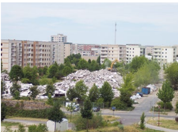
Flächenhafter Abriss von Wohnungen am Rand der Großwohnsiedlung Quelle: Bundestransferstelle
