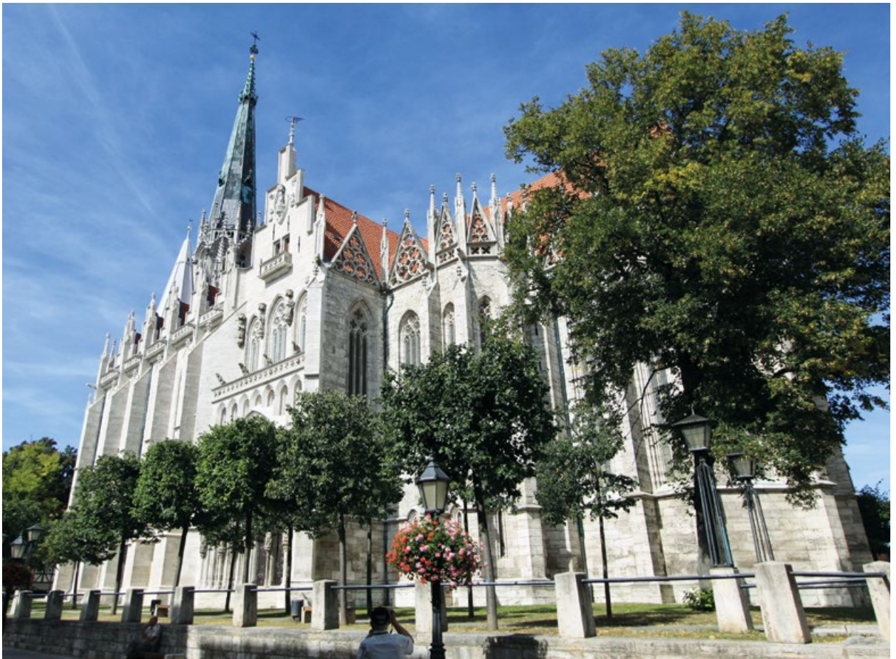
Durch Fördermittel sanierte Marienkirche Quelle: Stadt Mühlhausen
