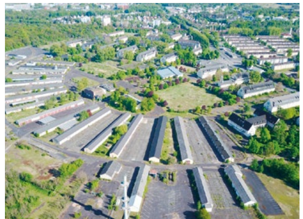
Luftbild Hanau: Erkennbar wird die einzigartige Fächerstruktur der Pioneer-Kaserne mit dem Housing-District »Triangle«. Quelle: LEG Hessen Hanau GmbH
