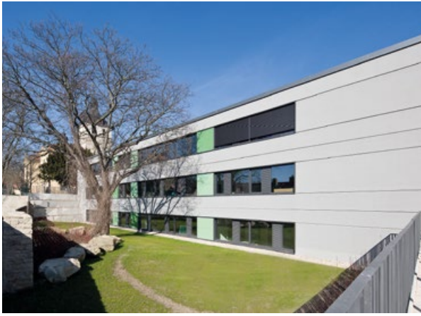
Erweiterungsbau des Campus Technicus mit Schlosskirche St. Aegidien im Hintergrund Quelle: Thomas Weiß, Erfurt
